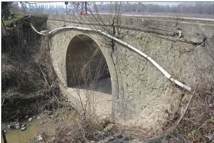
Vista del cavidotto fissato sul ponte esistente
