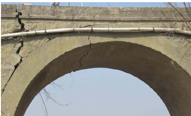
Dettaglio della fessura posta al di sopra del piedritto sinistro
